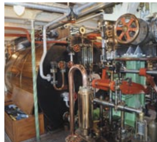
George Stephensons maskin och panna. Står på huvuddäck! Vinkeldrev till axeln.
