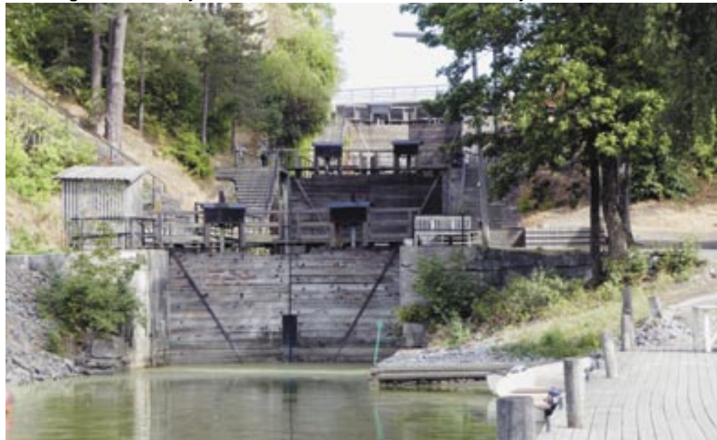
Engelbret Soot anlade 1849 här Norges första slussanläggning med tre slussar, höjdskillnad 10 m.
